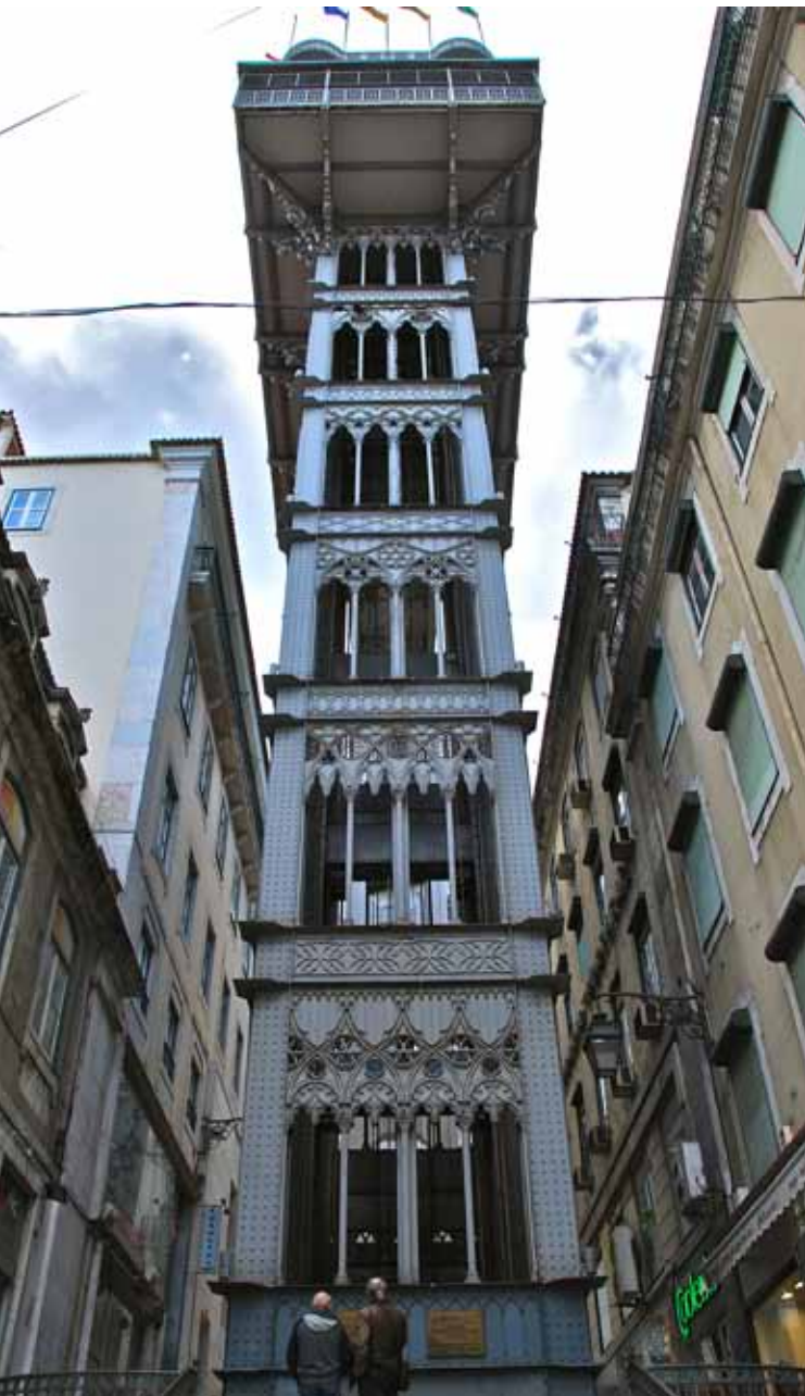
Elevador de Santa Justa en el barrio de Chiado, construido por un alumno de Eiffel.
